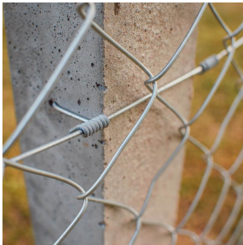
Figura 2: Forma de fixação da tela nos mourões.
